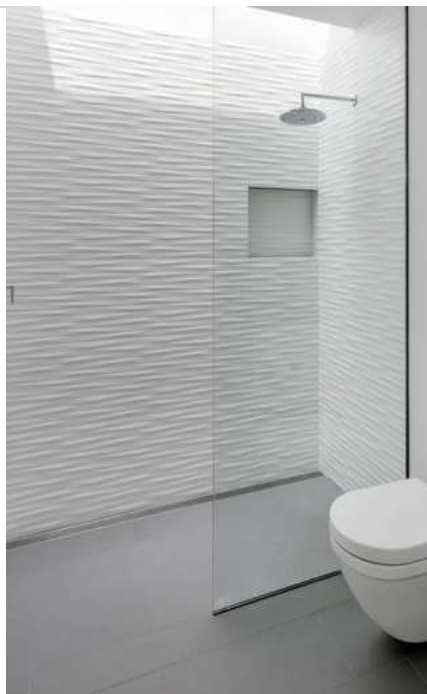
Plato de ducha de obra a medida (cerámica o microcemento)
